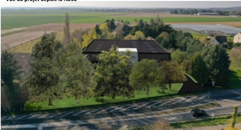
Vue du projet depuis la RD30
