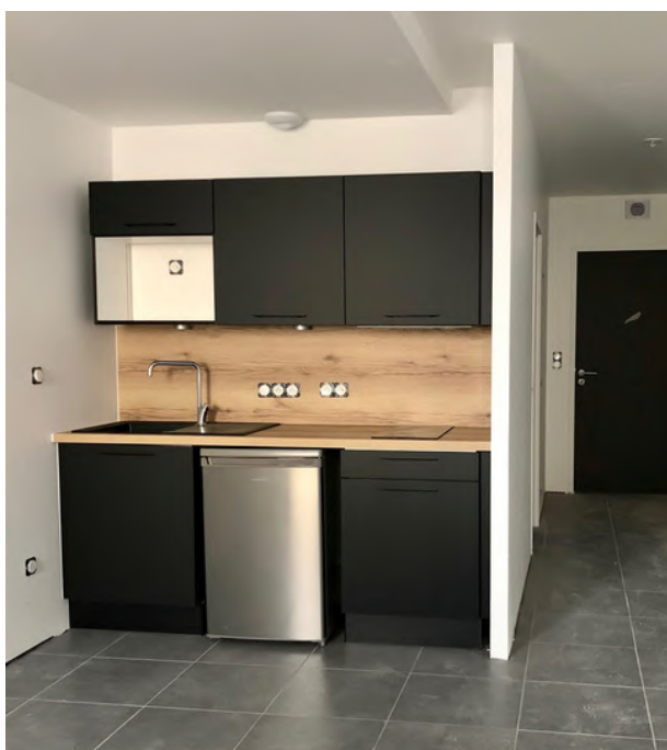
Exemple d'une cuisine installée
