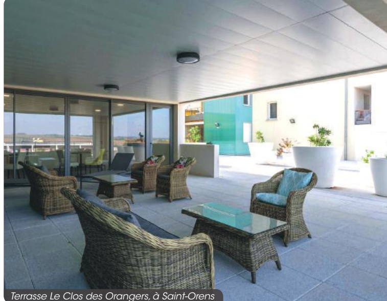
Terrasse Le Clos des Orangers, à Saint-Orens
