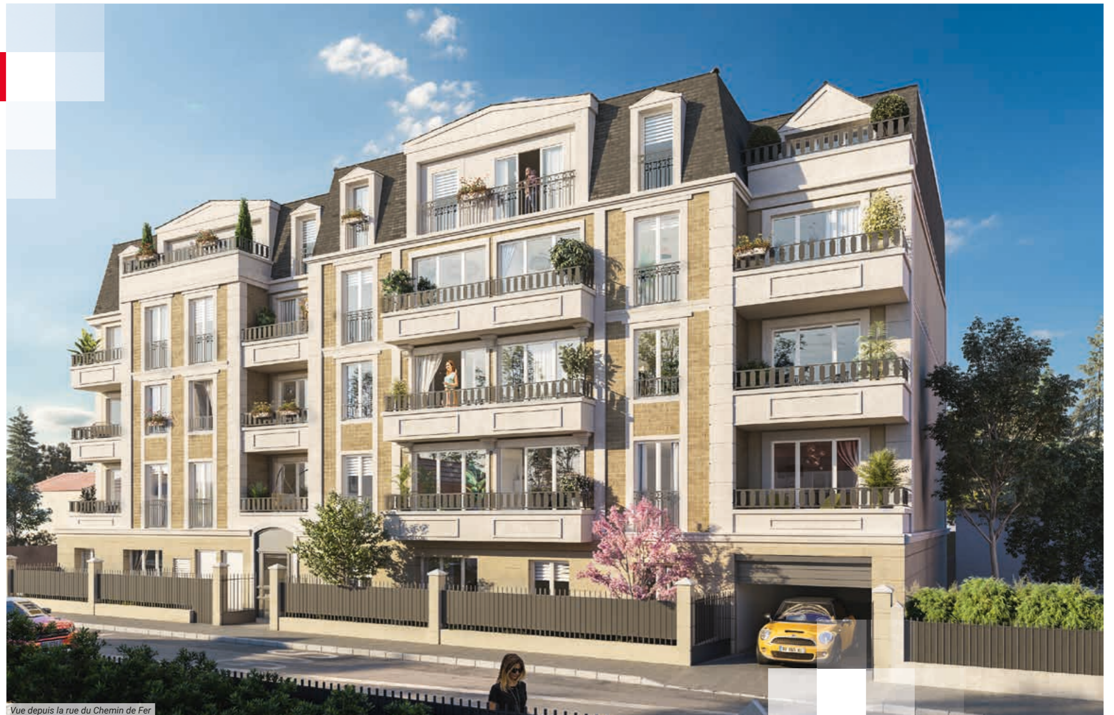
Vue depuis la rue du Chemin de Fer
