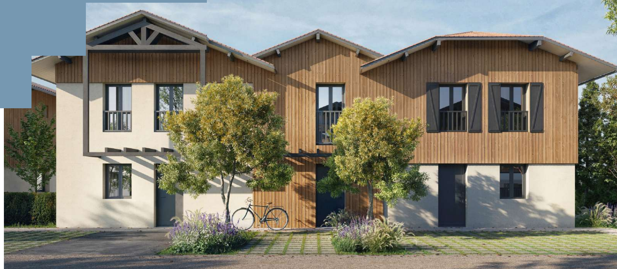
Les maisons 1G1, 1G2, 1G3 profitent d'entrées privées et arborées
