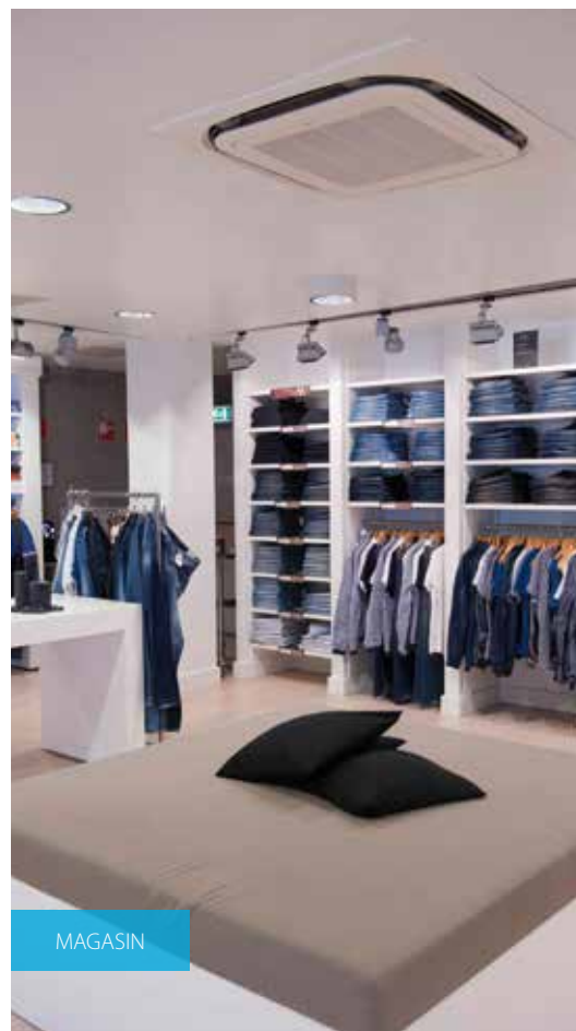
Cassette à soufflage circulaire FXFQ-A : Refolement de l'air à 360°, pour une efficacité et un confort optimum
