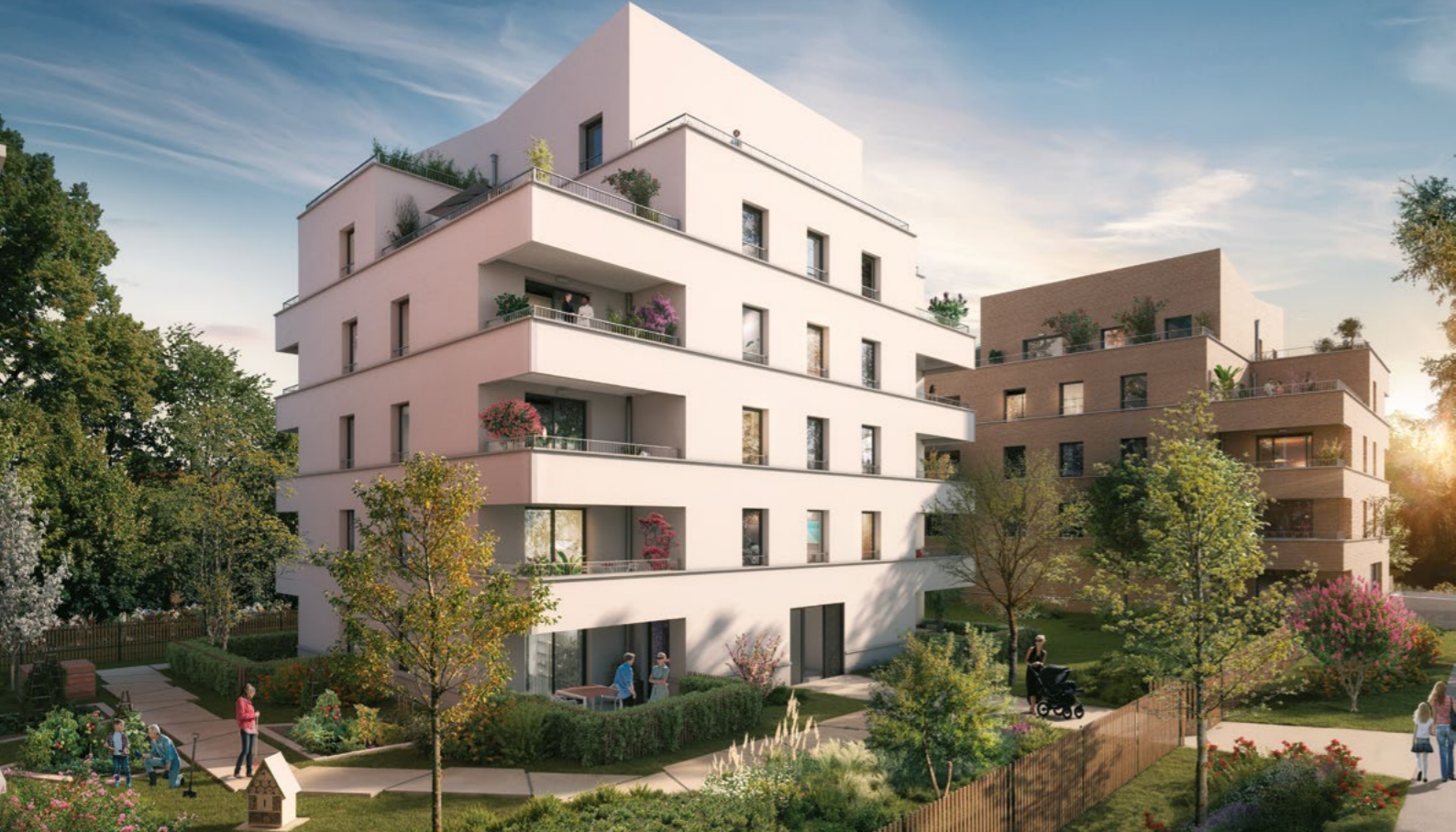
Vue du volet paysager et des espaces communs de la résidence
