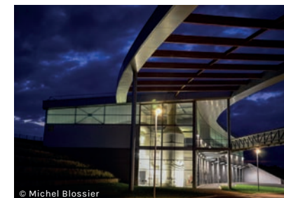
USINE DE TRAITEMENT DES EAUX USÉES DE CHARTRES MÉTROPOLE
