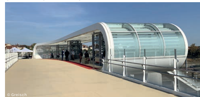
PASSERELLE DU PÔLE GARE DE CHARTRES
