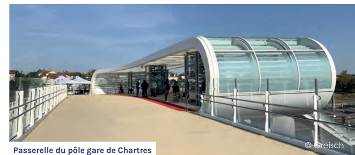
Passerelle du pôle gare de Chartres
