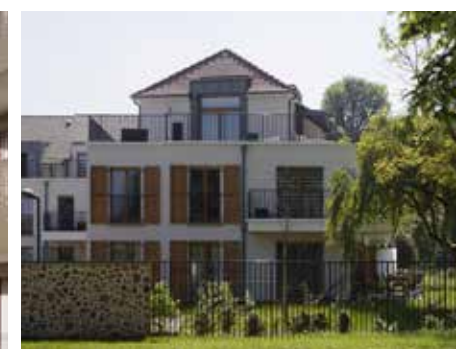
Villa Gabrielle au Mesnil-Saint-Denis / 77 Architecte Architectonia. Photo : D. Moulinet
