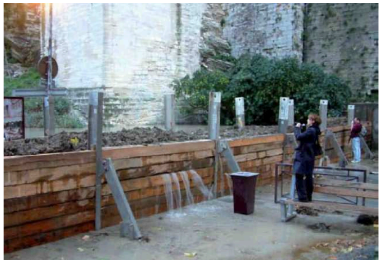
Dispositif de protection du parking rue Ferruce et photo du batardeau lors de la crue de 2003
