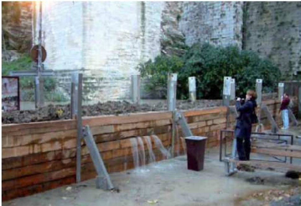
Batardeau du parking Ferruce durant la crue de décembre 2003
