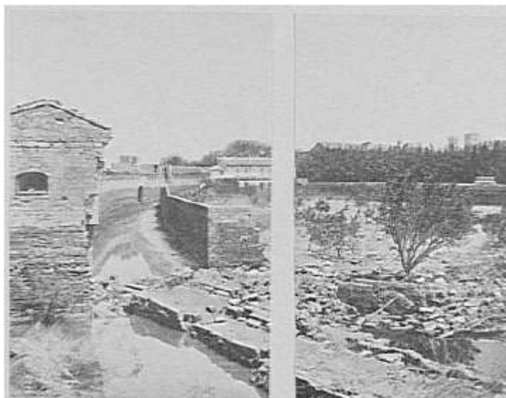
Remparts effondrés durant la crue de 1856 photographiés par Edouard Baldus à Avignon
