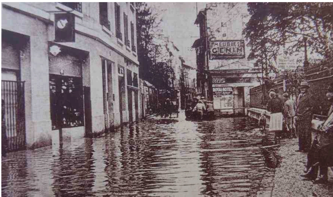
Crue de novembre 1935 : Avignon - rue Henri Fabre
