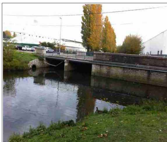
Pont de l'Allée de Challes / Stade-Verchère, amont
