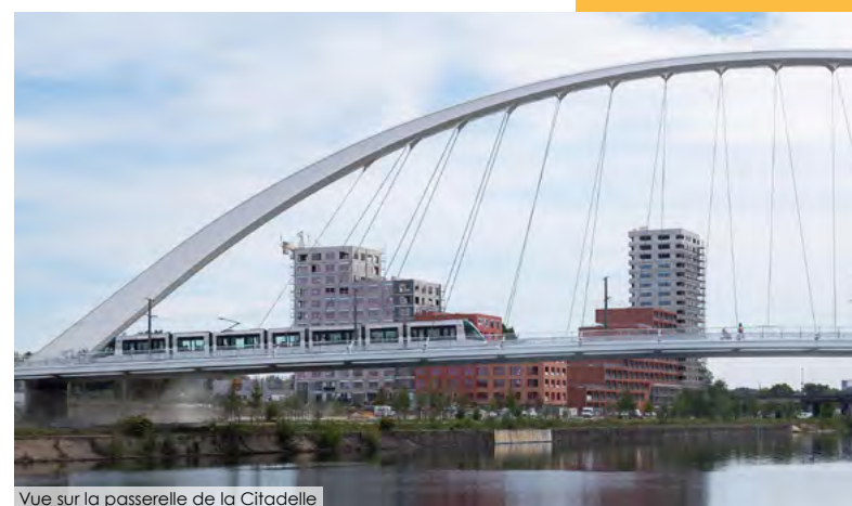
Vue sur la passerelle de la Citadelle
