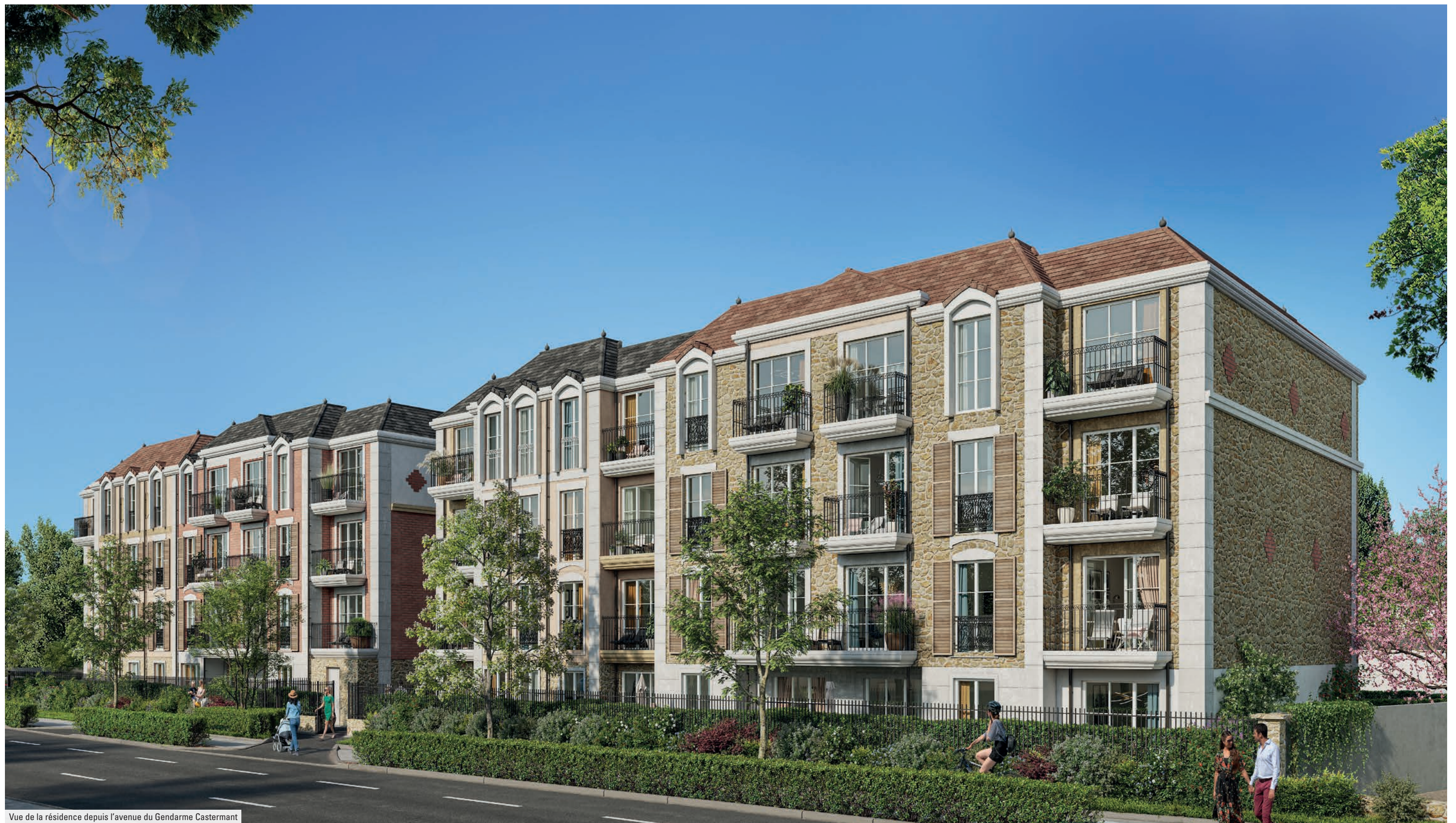
Vue de la résidence depuis l'avenue du Gendarme Castermant
