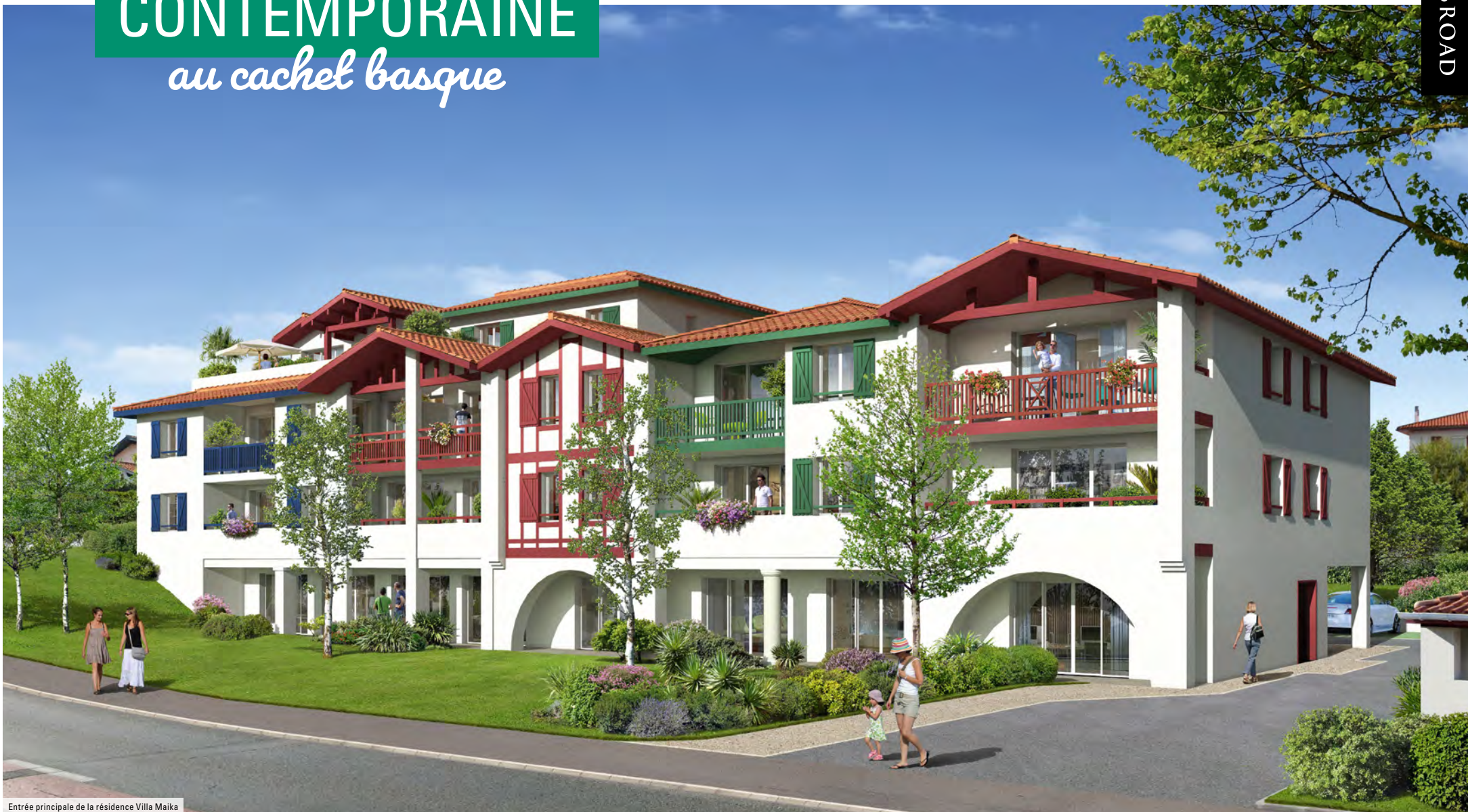
Entrée principale de la résidence Villa Maïka
