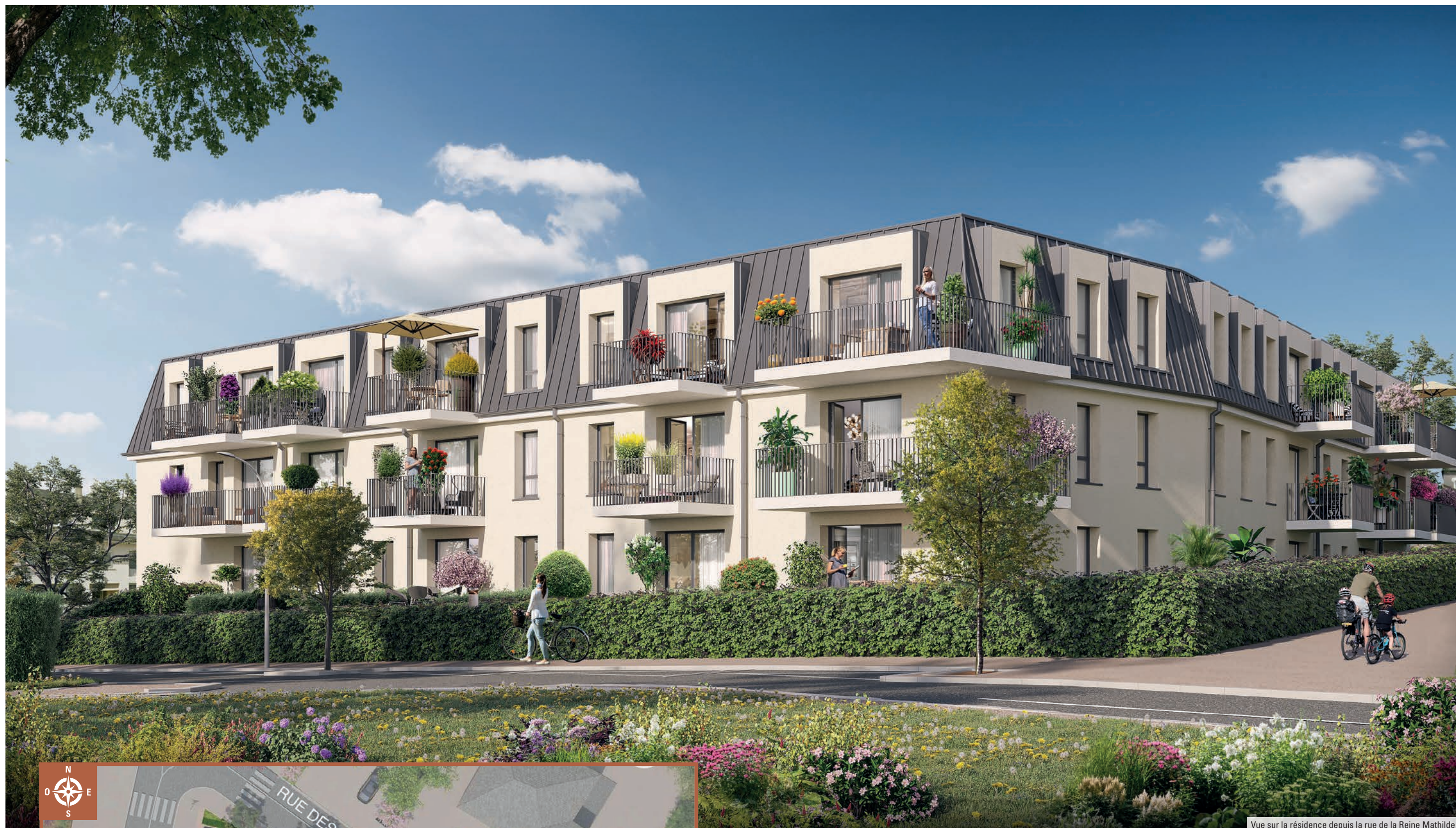
Vue sur la résidence depuis la rue de la Reine Mathilde
