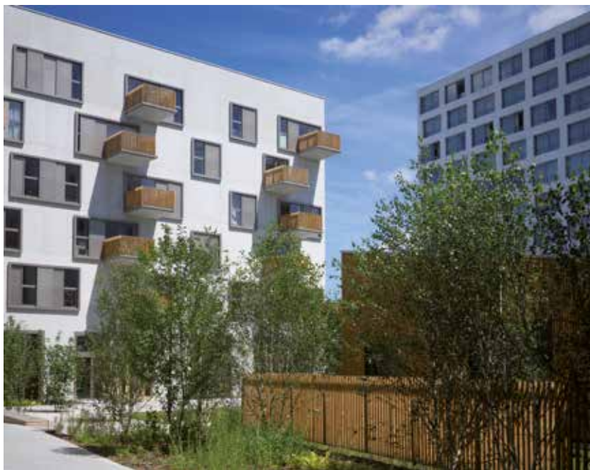
ILINK - Nantes - logements, bureaux et locaux activités
