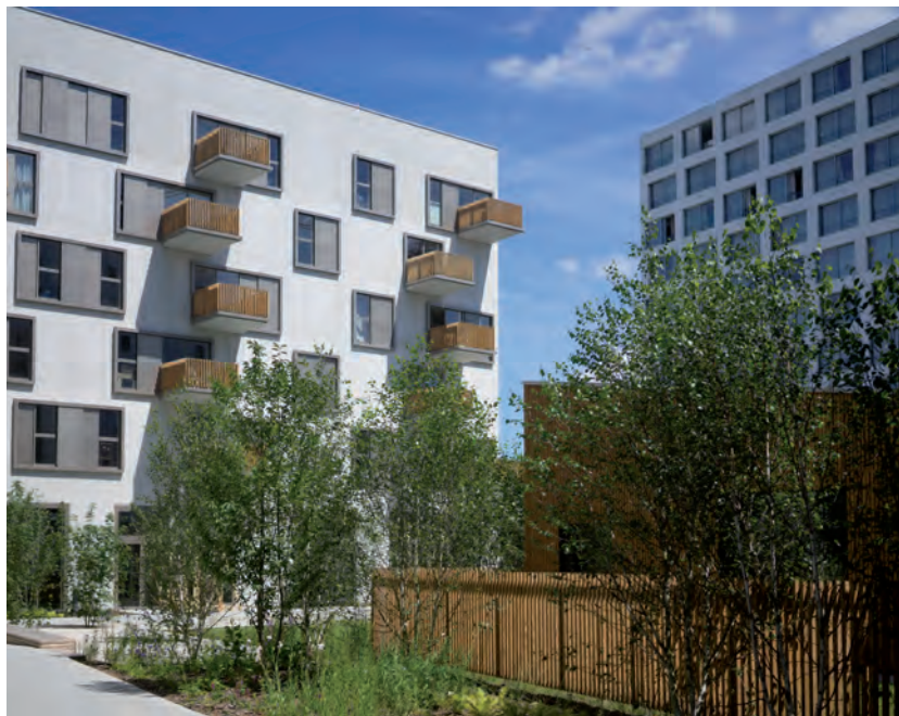
ILINK - Nantes - logements, bureaux et locaux activités
