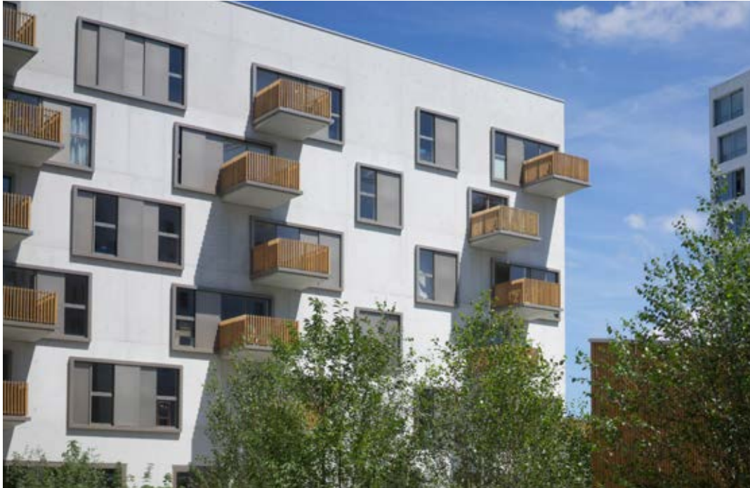
LOGEMENTS ET BUREAUX - Ilink - NANTES
