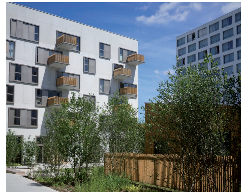
ILINK - Nantes - logements, bureaux et locaux activités
