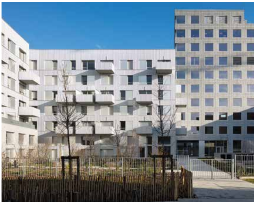
ILINK - Nantes - logements, bureaux et locaux activités
