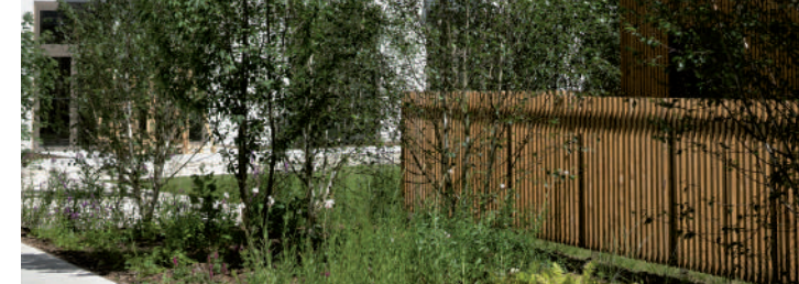
LOGEMENTS ET BUREAUX Ilink NANTES
