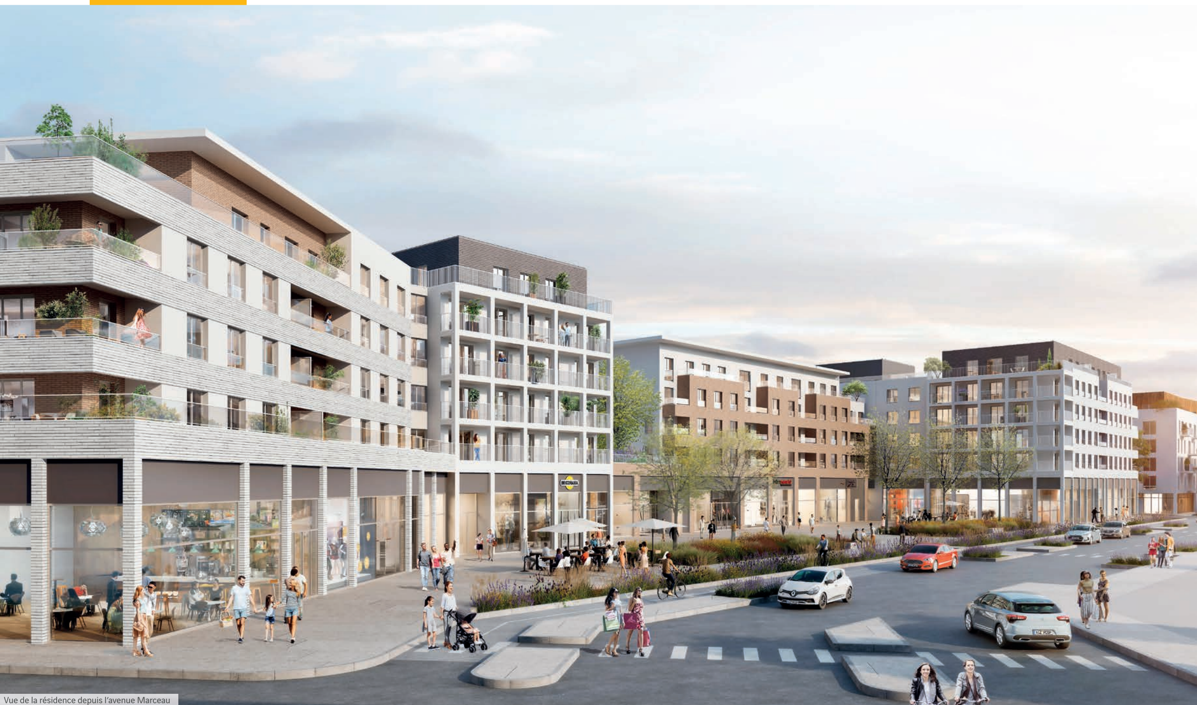
Vue de la résidence depuis l'avenue Marceau
