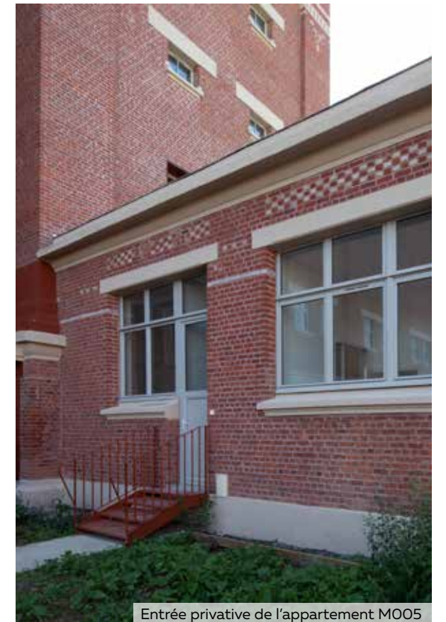
Entrée privée de l'appartement M005
