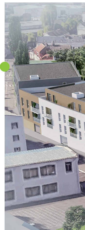
LA RÉSIDENCE Appartements collectifs
