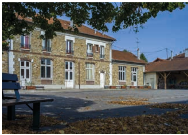
L'école Anatole France dans le Vieux Brevannes et son architecture préservée
