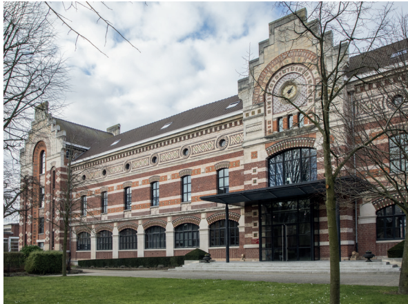
Le très beau Lycée Gustave Eiffel entièrement restauré à 1,3 km
