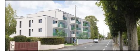
CONSTRUCTION D'UNE RESIDENCE SERVICE SENIORS
