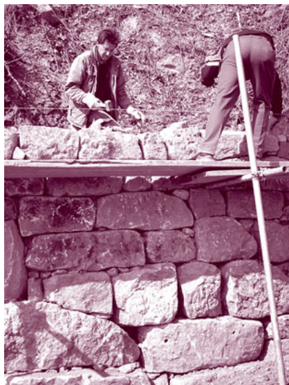
Domaine Schlumberger dans les Vosges : deux maçons remontent un mur de soutènement en assise de gros blocs.
