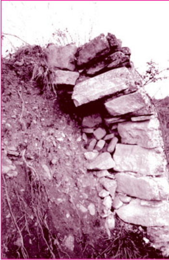
Brèche donnant la coupe d'un mur de soutènement en grès : de droite à gauche, le parement du mur formé de boutisses, le drain constitué de pierraille, la terre mêlée de cailloux ou d'esquilles.
