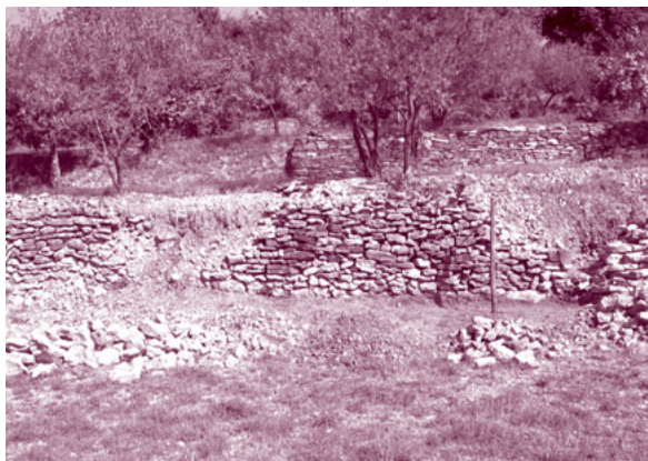
Les pierres éboulées ont été retirées et mises en tas en aval du chantier en vue de leur emploi.
