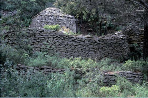
Le corps de base de la cabane est un parallélépipède au fruit marqué ; le couvrement est un cône surbaissé à couverture de grosses lauses et à rives saillantes. (Cornillon-Confoux, Bouches-du-Rhône.)
