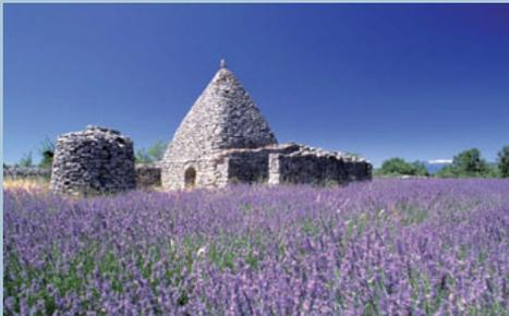
Ensemble constitué par une cabane et son mur pare-vent, un appentis (autrefois en tuiles canal) et un puits couvert. La cabane est surmontée d'une pyramide aux faces curvilignes et aux angles arrondis. (Saignon, Vaucluse.)
