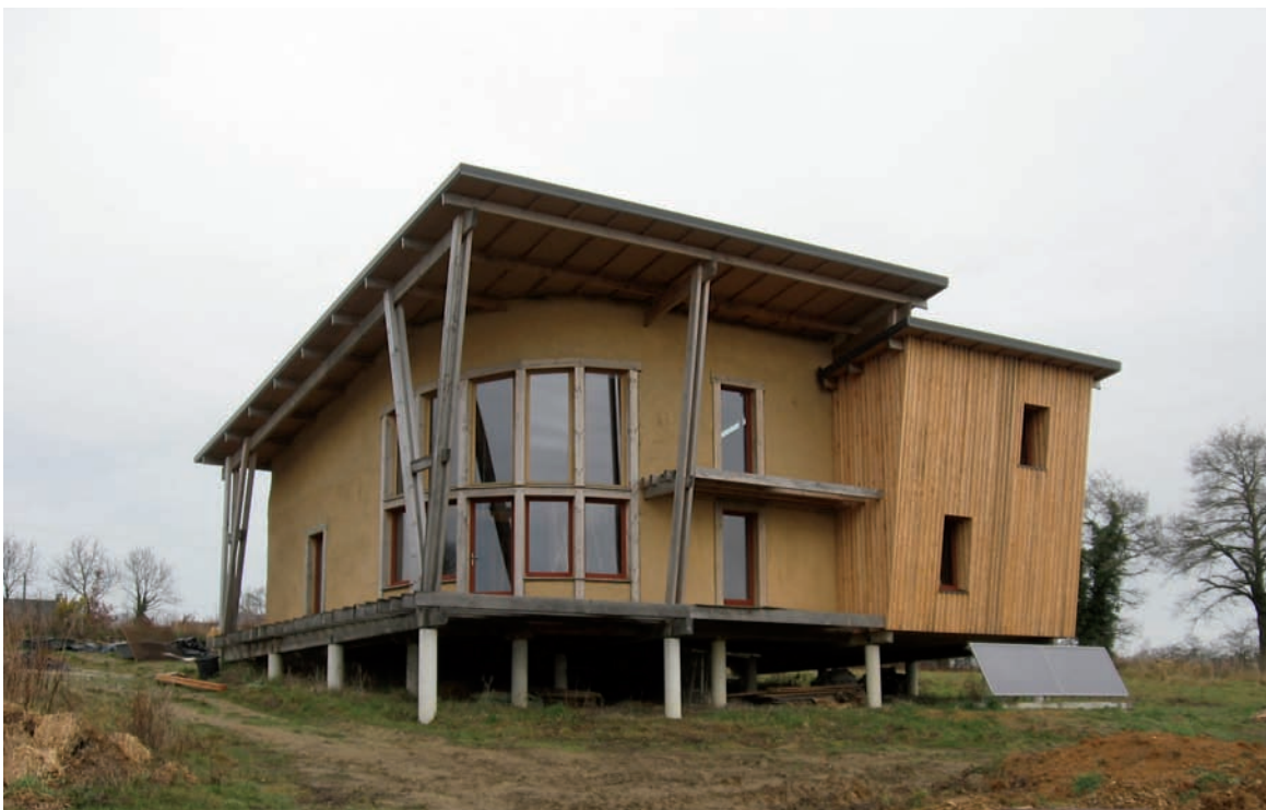
Pour couler ces poteaux de béton, on peut utiliser des moules circulaires (en vente chez les fournisseurs de matériaux), après y avoir introduit ce qu'il faut de « ferraille » pour armer le béton. Il y a une cave qui, au cours des travaux, s'est remplie d'eau entrée... par les gaines électriques. On y a remédié en perçant celles-ci avant qu'elles pénètrent le mur.
