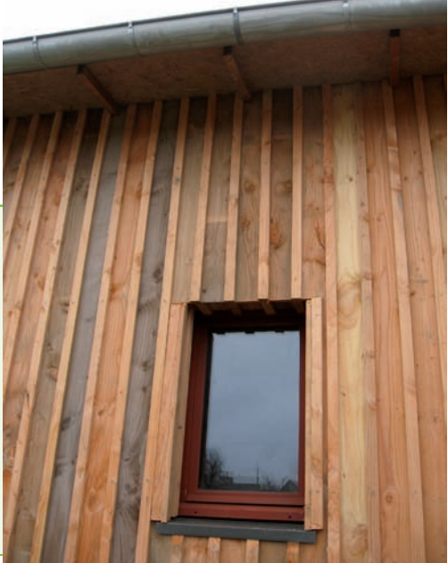
Détail du bardage : remarquez les dalles OSB, sous la gouttière.
