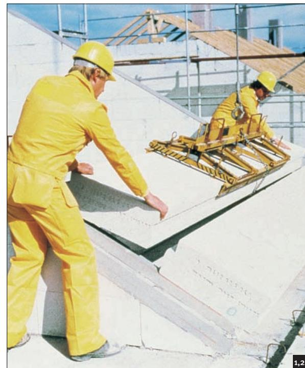
les murs porteurs transversaux. Elles sont dimensionnées et fabriquées sur mesure en usine selon un plan de calepinage.
