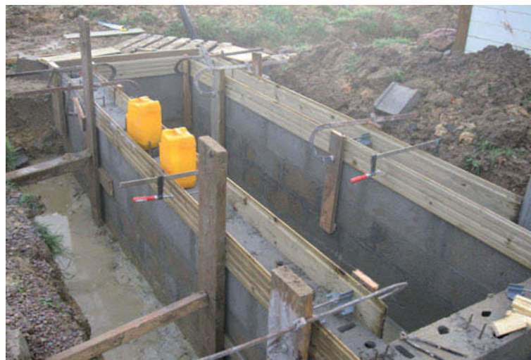
Construction d'un réservoir enterré en parpaings de 30 m 3 .
