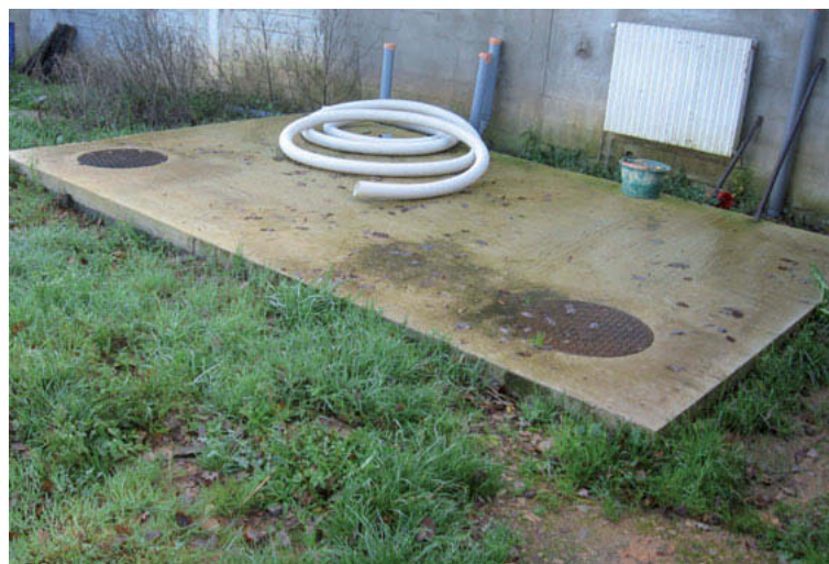
Construction d'un réservoir enterré en parpaings de 30 m 3 .
