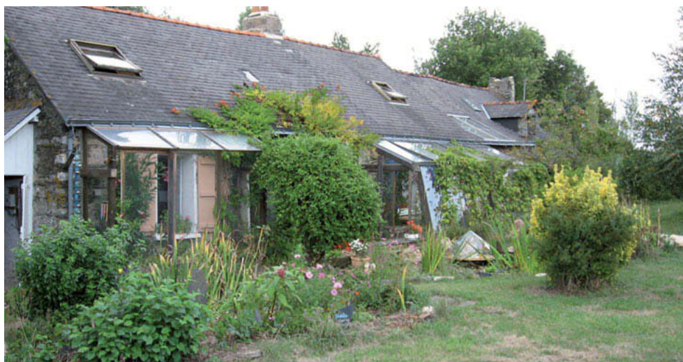
Maison des Baronnet en Loire-Atlantique: au sud, une simple serre faite avec des verres de récupération isole la maison et concentre les rayons du soleil sur la masse des murs.
