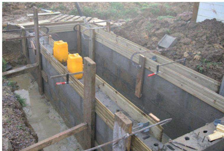
Construction d'un réservoir enterré en parpaings de 30 m<sup>3</sup>.
