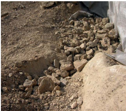
Figure 69 Ce drain évite à l'eau de stagner dans la cuvette creusée lors du terrassement pour donner du fruit aux blocs de fondation.
