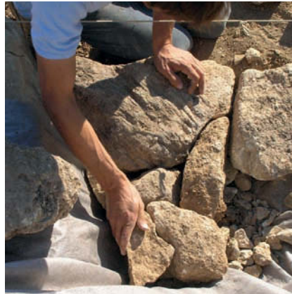
Figure 78 Selon les mêmes critères de stabilité et de coïncidence entre les pierres, le mur est maçonné dans sa profondeur (vue de dessus).
