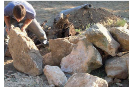
Figure 80 Utilisez les plus gros blocs pour les fondations.
