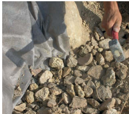
Figure 70 Le drain est damé et compacté.
