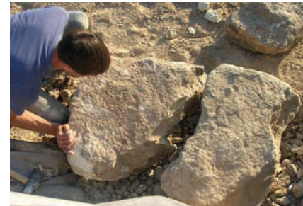
Figure 81 Les blocs doivent coïncider au plus près.
