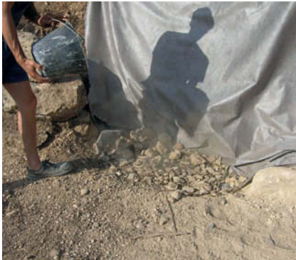
Figure 66 Le cailloutis est étalé sur l'assise du mur.
