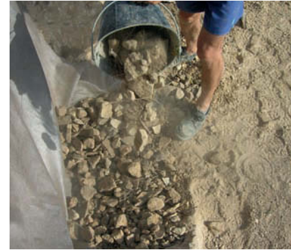
Figure 68 Remplissez ces exutoires de cailloutis.
