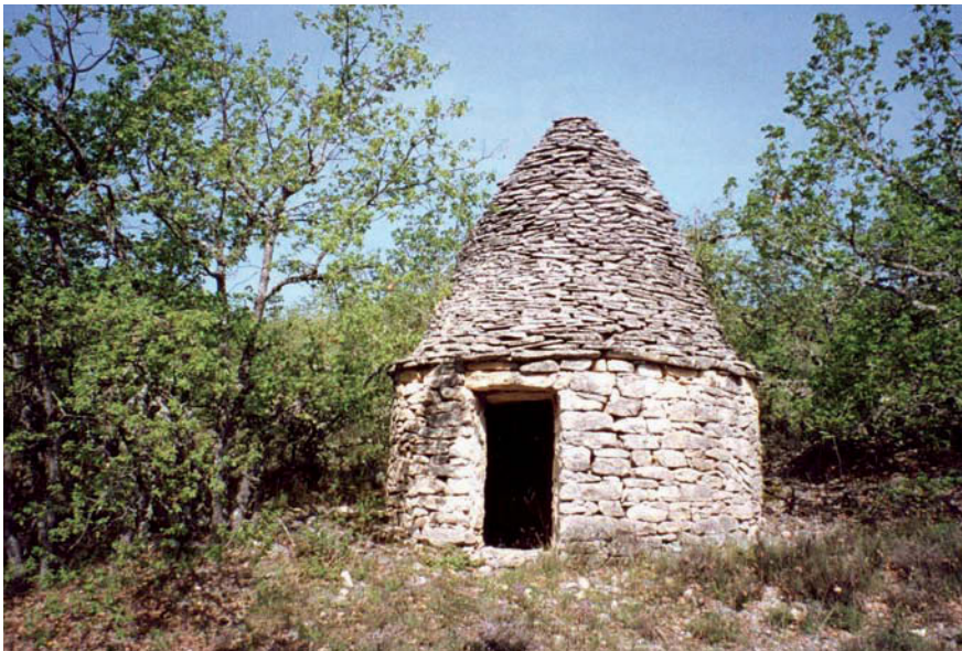
Figure 3 Cabanon dit pointu dans les Alpes-de-Haute-Provence.
