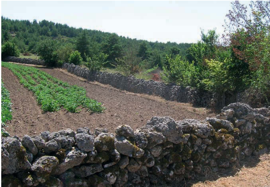
Figure 4 Mur d'enclos d'un potager en Aveyron.
