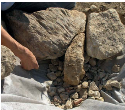
Figure 77 La troisième pierre, s'insère et cale les deux premières (vue de dessus).
