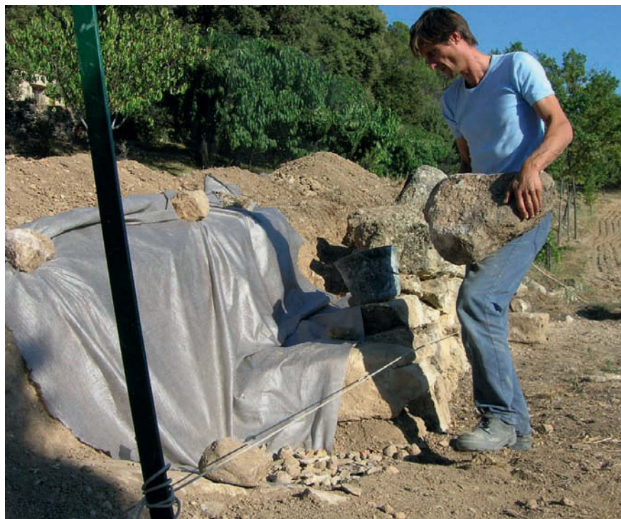
Figure 72 Si le mur n'est pas haut, il n'est pas nécessaire d'utiliser de très gros blocs.
