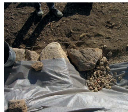
Figure 74 Vue de dessus, de la pierre posée.
