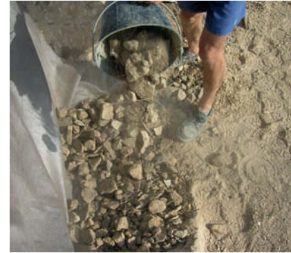
Figure 68 Remplissez ces exutoires de cailloutis.
