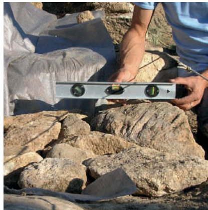
Figure 79 Le niveau à l'horizontale confirme le fruit des pierres installées (vue de profil).
