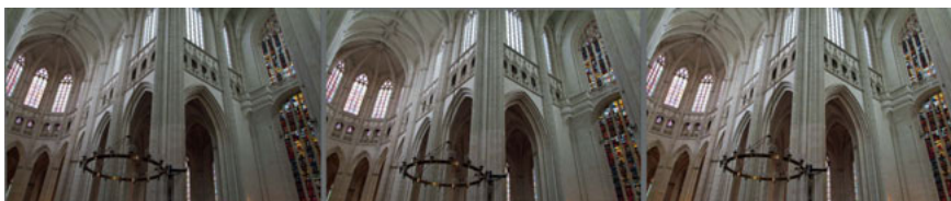
Sur cette image en tons moyens, les trois réglages possibles du DxO Lighting aboutissent presque au même résultat, sauf dans les ombres sous la voûte.
