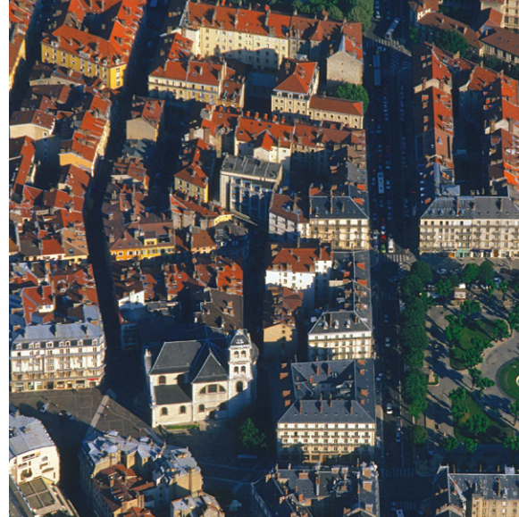
12 LES GRANDS TRAVAUX D'HAUSSMANN
