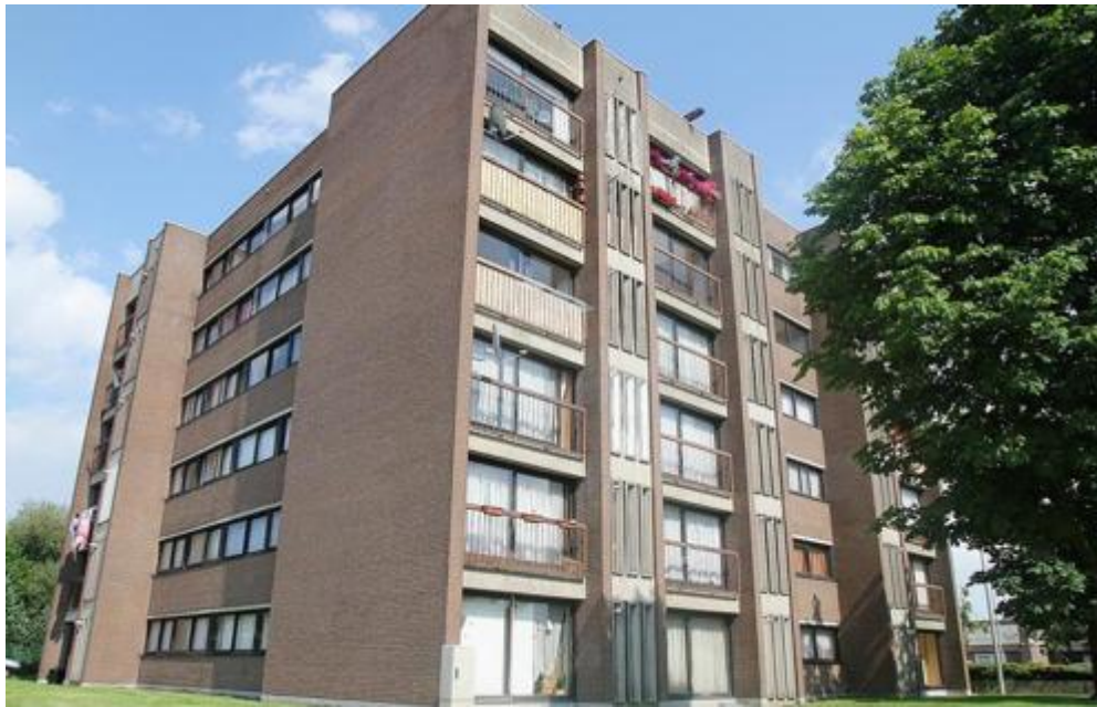
Faute de chauffage et avant de lourds travaux, le bloc 91-93 devra être évacué dans les trois mois.
